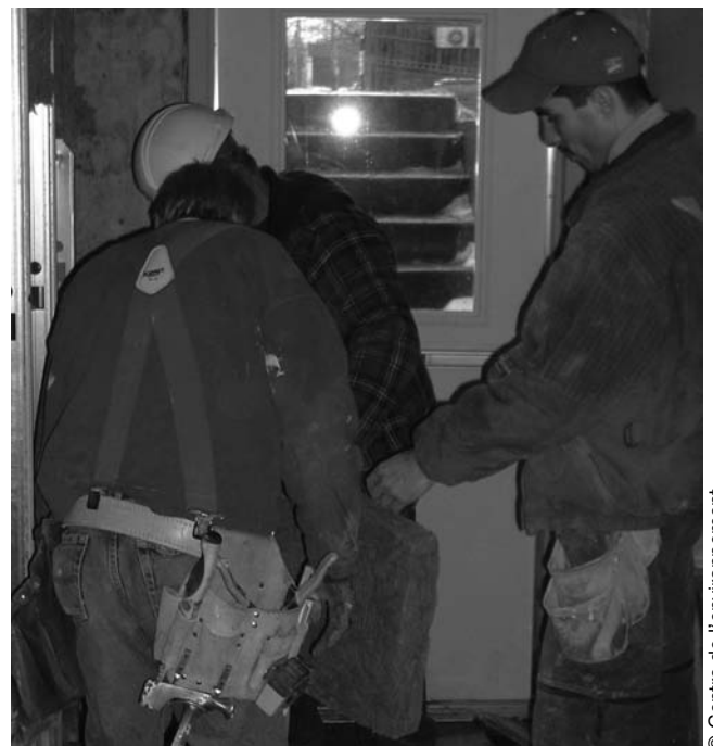
Chantier du Centre culture et environnement Frédéric Back
